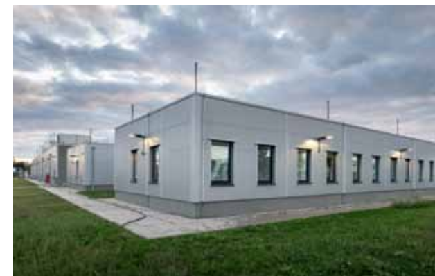
Rechenzentrum Leipzig: 1.400 m 2 , PUE-Zielwert 1,2
